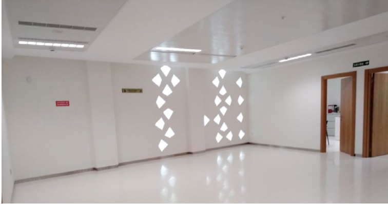
Foto 10: Instalaciones de los Equipos Psico-sociales de Córdoba
